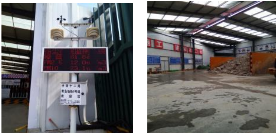
图 11.1-1 在建青岛地铁施工期施工临时工棚
