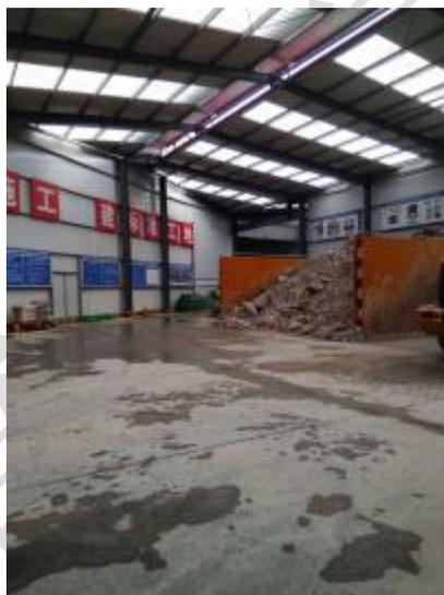
（4）对工程不能及时运走的土石方应采用施工棚内堆放，根据水土保持要求进行植物防护和工程防护措施，减少水土流失。
