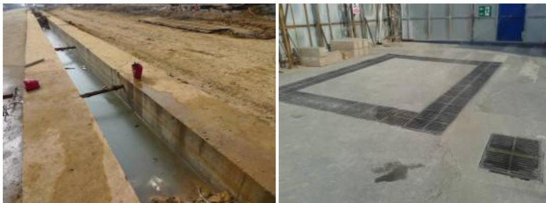
根据设计提供的基坑涌水量如下，车站基坑开挖的涌水量预计为 270m<sup>3</sup>/d，车站涌水抽出沉淀后可以直接排入雨水管网。
