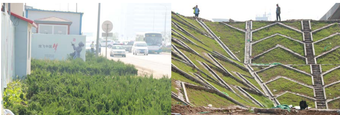
车辆段与综合基地地区综合骨架防护及施工区植物措施
