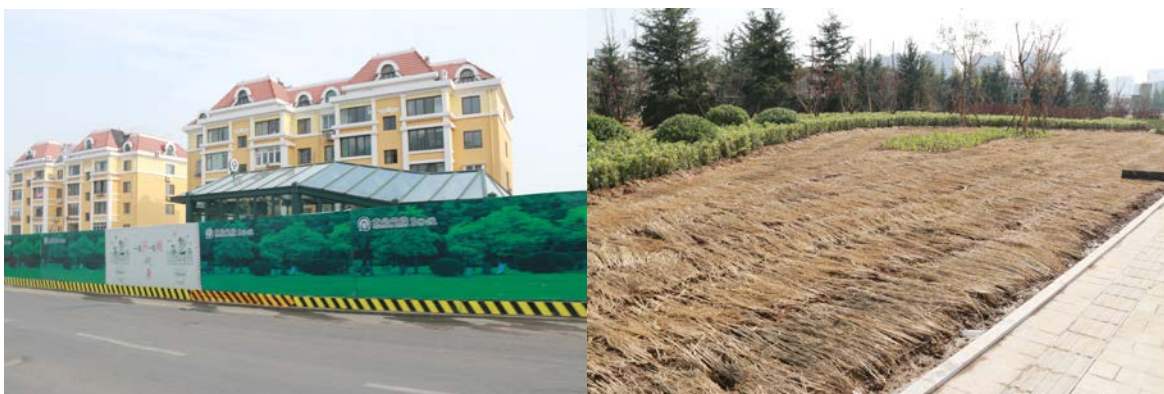
车站防治区临时围挡及临时苫盖防护措施
