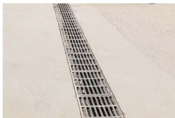
车辆段与综合基地地区施工临建临时排水设施
