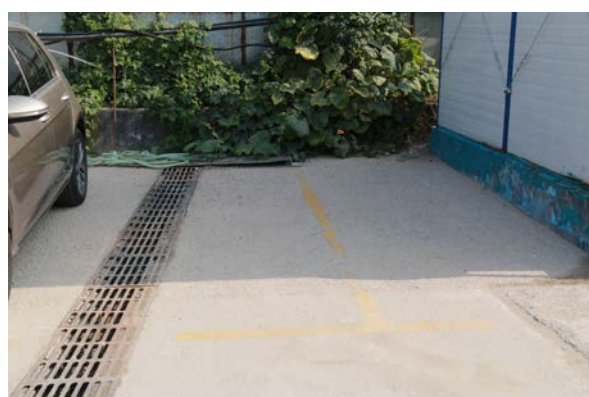
车辆段与综合基地地区施工临建临时排水设施
